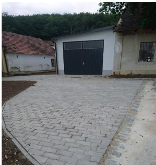
Pflasterung vor dem „Kasino“ mit großer Unterstützung der Mitglieder der Freiwilligen Feuerwehr
