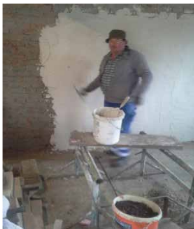
In Patzmannsdorf wurden die Verputzarbeiten im Gerätehaus am Friedhof durchgeführt
