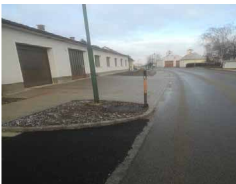
Unterschoderlee – Weiterführung der Errichtung der Nebenanlagen
