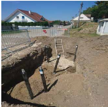
Neuer Schieber für die Wasserversorgung
