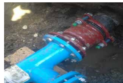
Hydrantentausch beim Friedhof und Richtung Kellerasse
