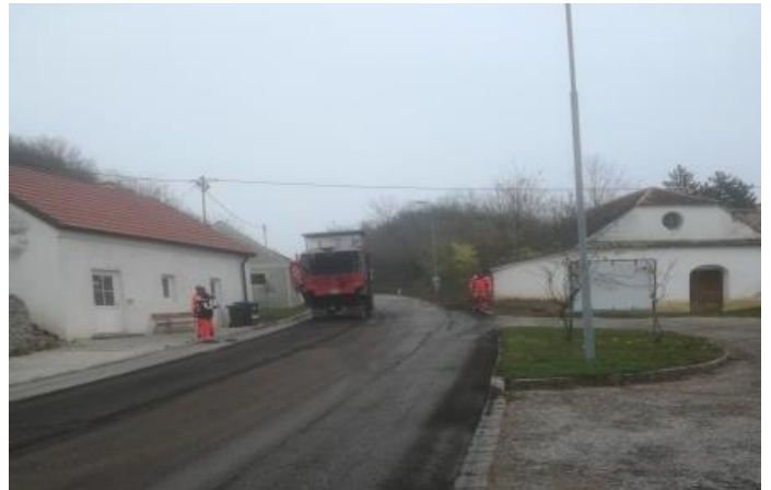
Asphaltierung der Landesstraße Richtung B6 und Richtung Stronsdorf
