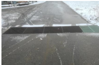
Nach einer Beschädigung wurde das große Einlaufgitter in Patzenthal repariert
