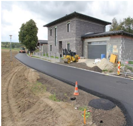
Herstellung des Kanals für die Oberflächenentwässerung und Asphaltierung in der Pfarrsiedlung in Patzmannsdorf
