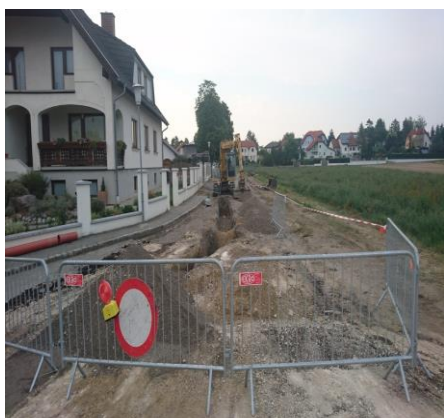
Herstellung des Kanals für die Oberflächenentwässerung und Asphaltierung in der Pfarrsiedlung in Patzmannsdorf
