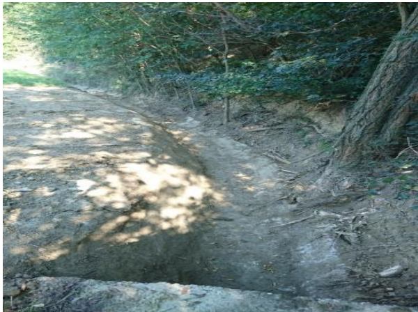
In Oberschoderlee wurden bei der ehemaligen Bauschuttdeponie die Gräben ausgeräumt und der Wasserablauf wiederhergestellt
